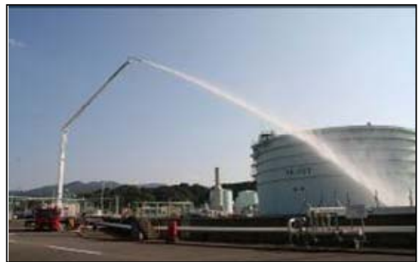
タンクへの冷却散水
