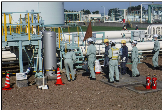
陸上訓練：漏洩停止措置、油回収作業
