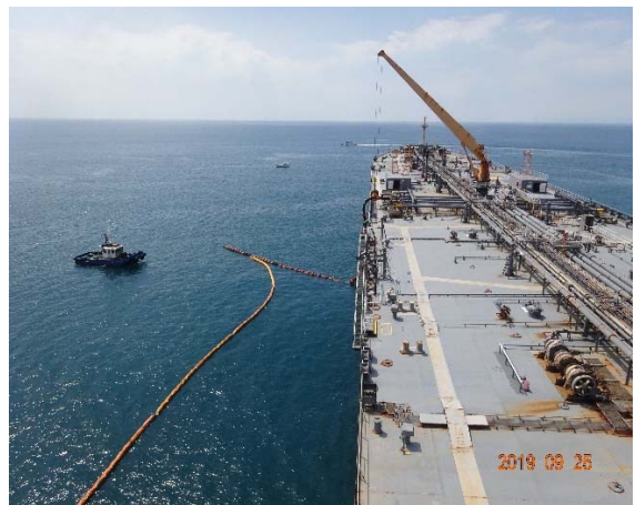
オイルフェンス展張完了
