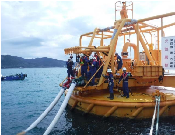
係留索 SPMへ接続完了
