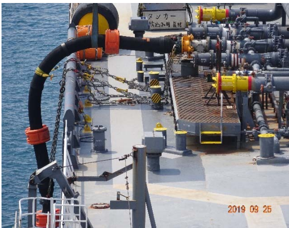
浮沈ホース取付完了
