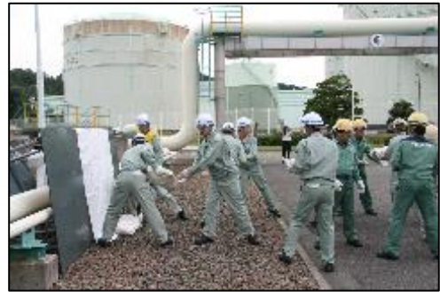
防油堤亀裂部への土嚢構築
