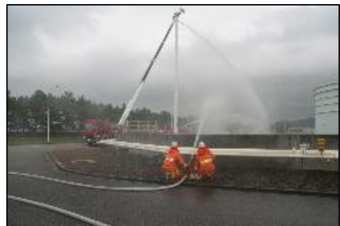
タンクへの冷却散水
