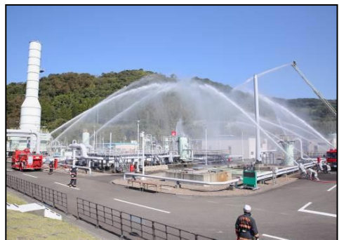
消火延焼防止訓練（一斉放水）
