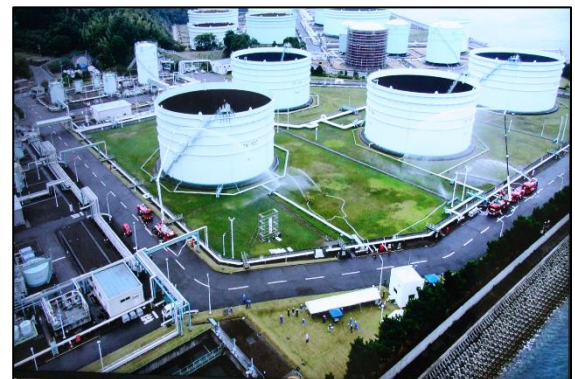
冷却散水（ドローン映像）
