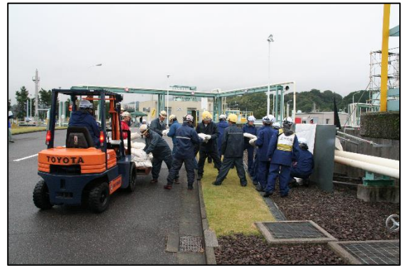
防油堤亀裂部への土嚢構築
